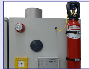
CO 2 -Feuerunterdrückungseinrichtung
